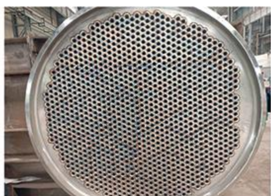
管端机器人自动焊接 Pipe End Robot Automatic Welding
